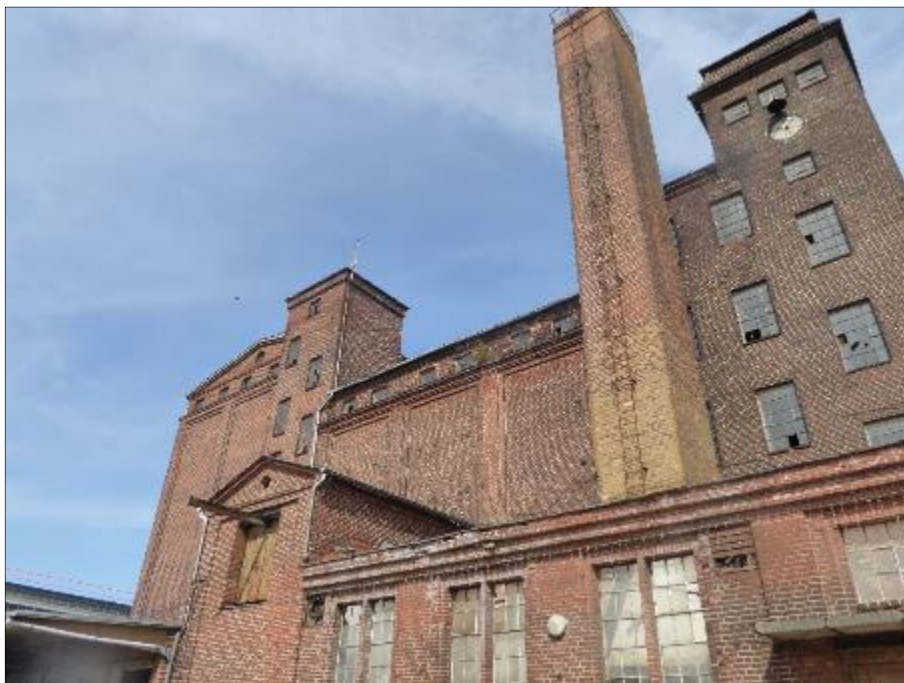
Abb. 4: Blick auf die alte Mühle mit bis zu sieben Vollgeschossen in den beiden Türmen (Foto 30.06.2022).
