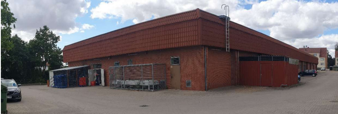
Bild 16 Blick auf die Ladezone des Edeka-Marktes mit Verflüssiger, Aufnahme vom 26.07.2022
