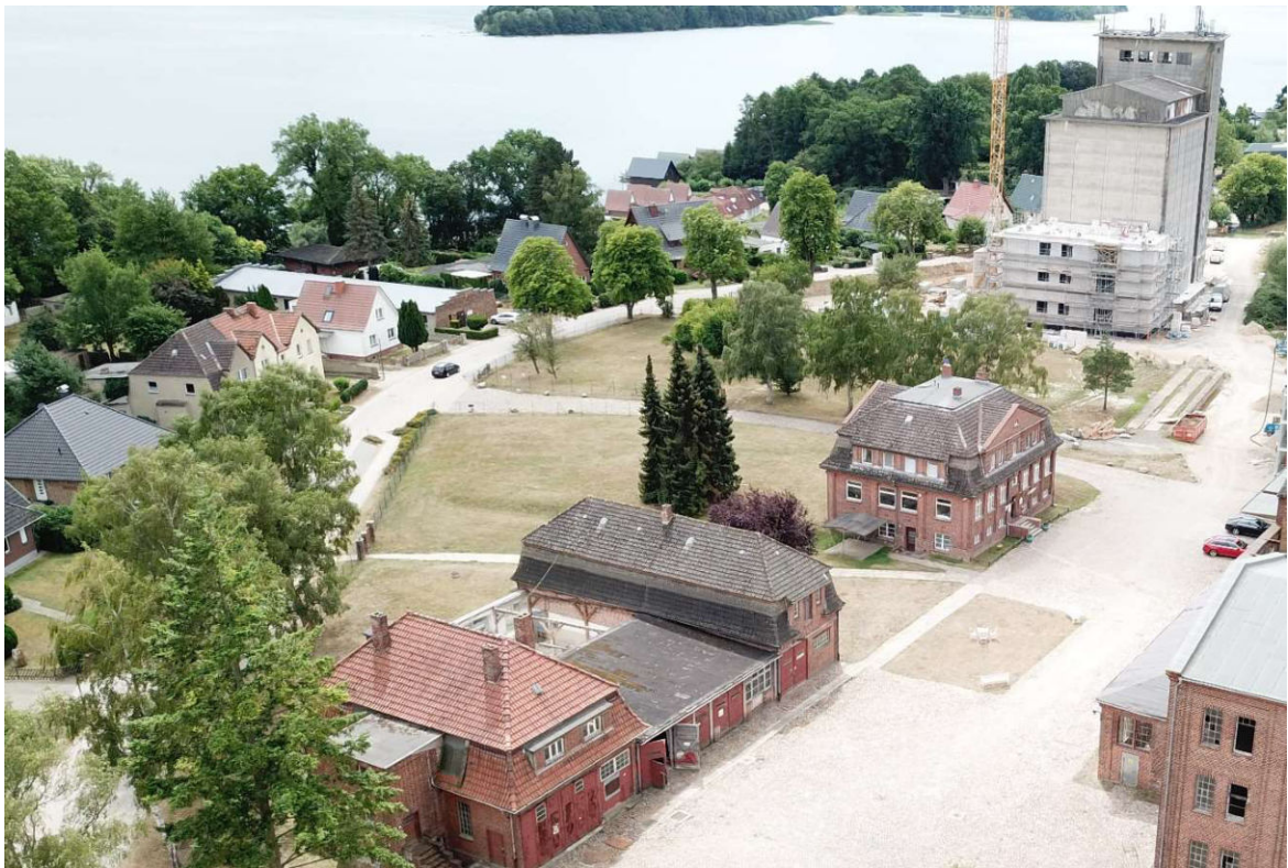
Bild 19 Blick Richtung Süden über das Plangebiet und die Gebäude östlich des Uferweges, Aufnahme vom 26.07.2022
