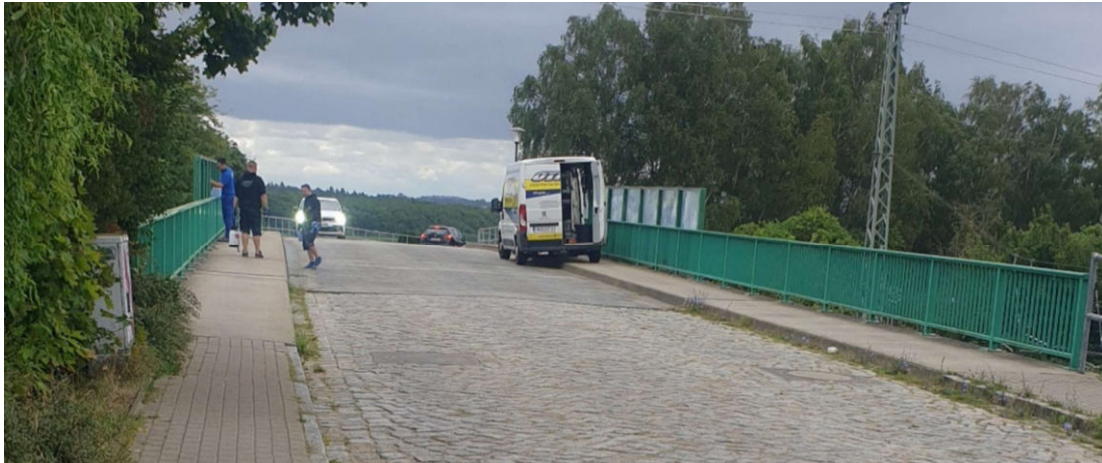
Bild 8 Blick Richtung Osten über die westliche Rampe der Eisenbahnbrücke Mühlenstraße, Aufnahme vom 26.07.2022
