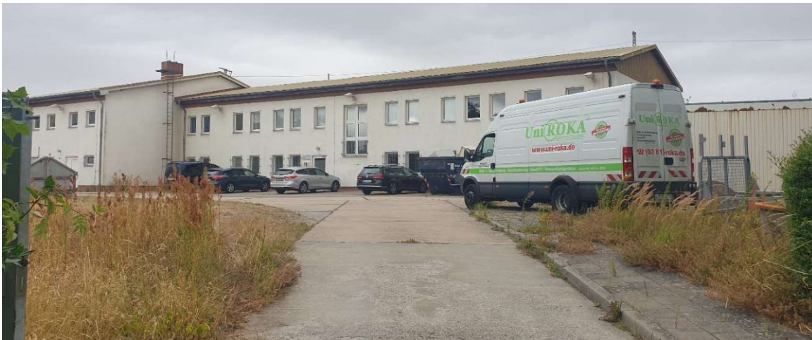
Bild 13 Blick Richtung Nordwesten auf das Betriebsgelände der DB Bahnbau Gruppe GmbH mit Bürogebäude und Parkplatz, Uferweg 23a, Aufnahme vom 26.07.2022
