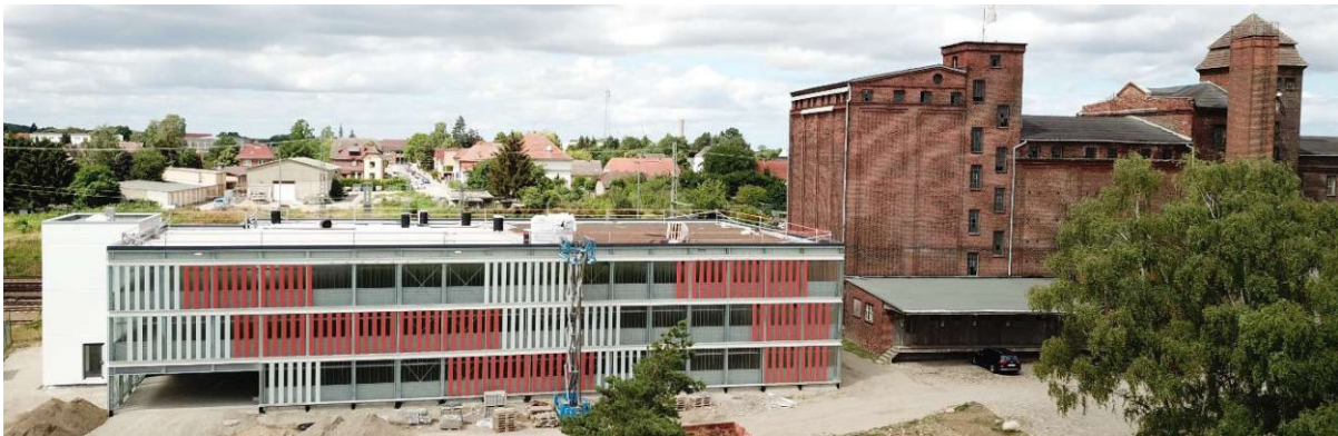
Bild 28 Blick Richtung Nordwesten über das SO Parkhaus, Aufnahme vom 26.07.2022
