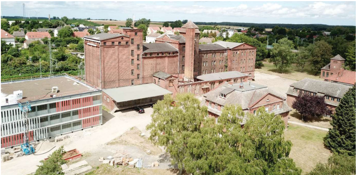
Bild 2 Blick über das Plangebiet Richtung Nordwesten mit dem neu errichtetem Parkhaus sowie dem Mühlengebäude MU6, Aufnahme vom 26.07.2022
