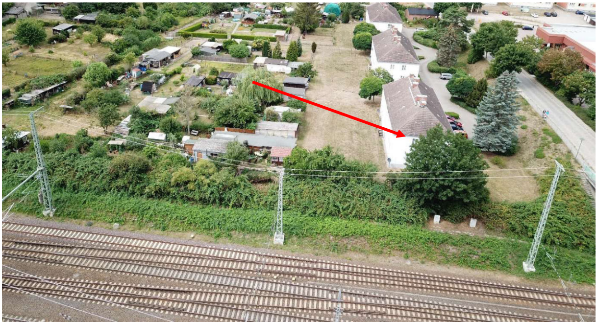
Bild 20 Blick Richtung Nordosten auf das Wohngebäude Mühlenstraße 3 (IO 27), Aufnahme vom 26.07.2022
