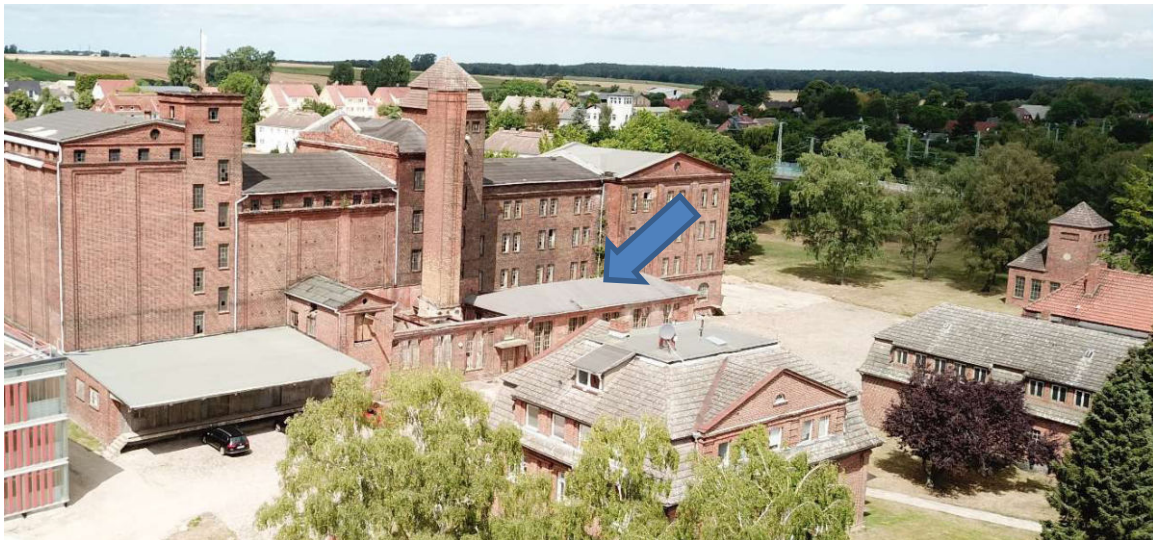
Bild 25 Blick über das Mühlengebäude mit dem alten Maschinenhaus Richtung Norden, Aufnahme vom 26.07.2022
