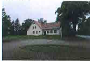
BESTAND BÜCKERDING STRASSE RICHTUNG KIRCHE I (VOM PARKPLATZ AUS)
