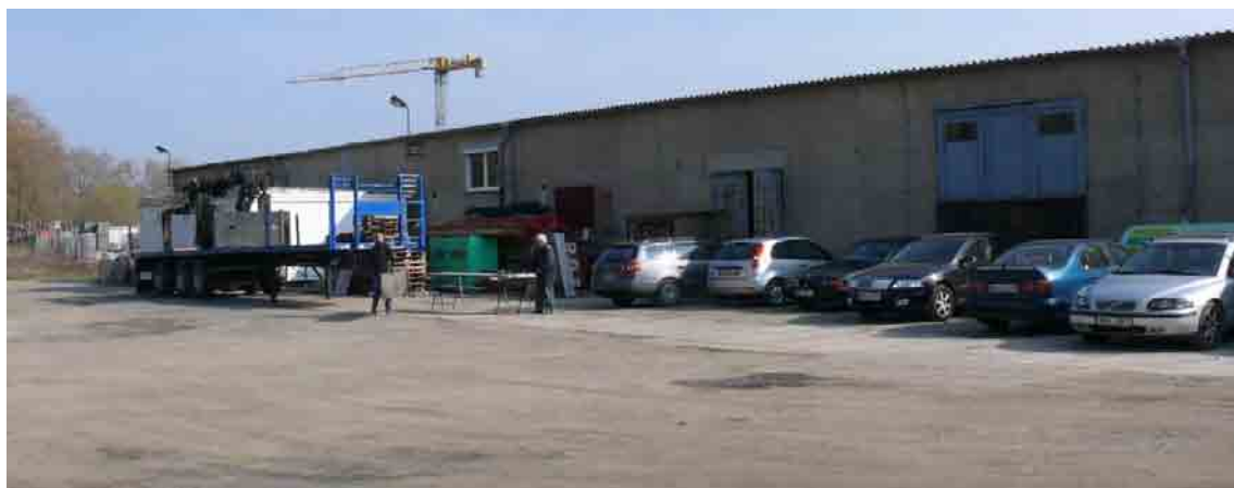
Abbildung 7: Teilversiegelte Fläche im Südwesten des Plangebietes. Quelle : Stadt Land Fluss 03.04.2014.
