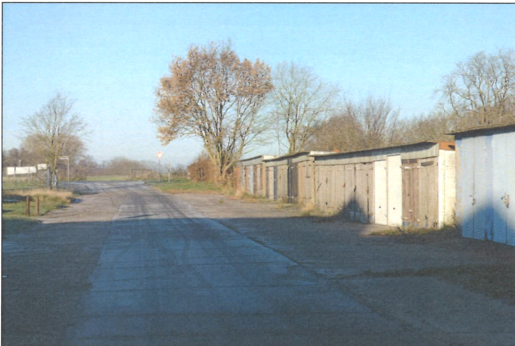
Abbildung 10: Ansicht der Straße „An der Wirtschaftstraße“ mit Garagen, die außerhalb des Plangeltungsbereiches liegen.
