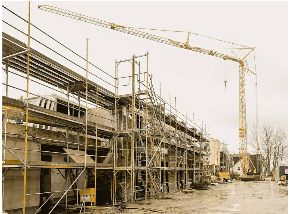
Stand der Rohbauarbeiten Mitte Februar
