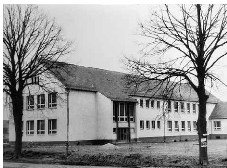
Neubau der Schule in Lübow 1962
