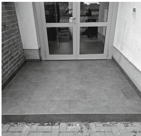
Eingangsbereich des Dorfgemeinschaftshauses
