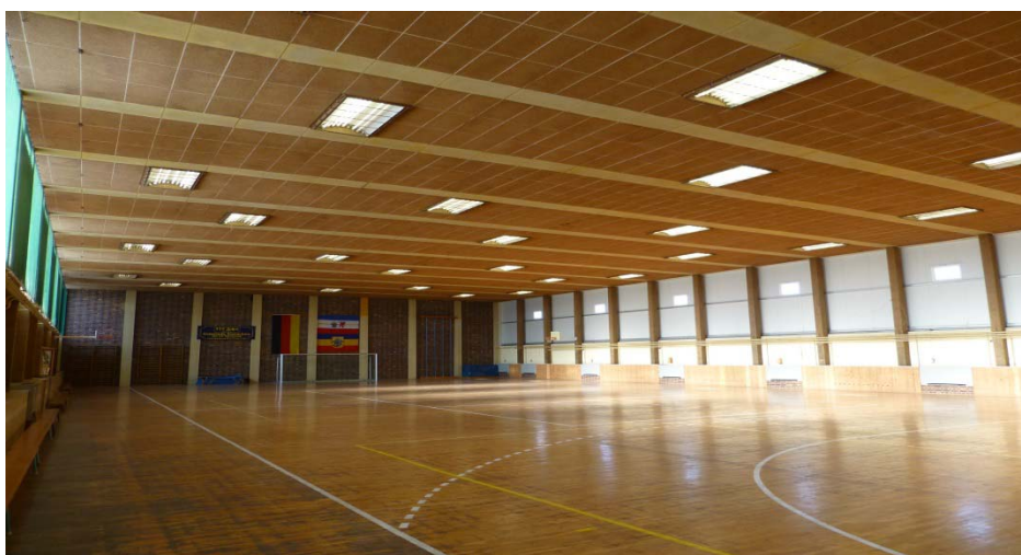
Alte Anlage mit LS-Leuchten
